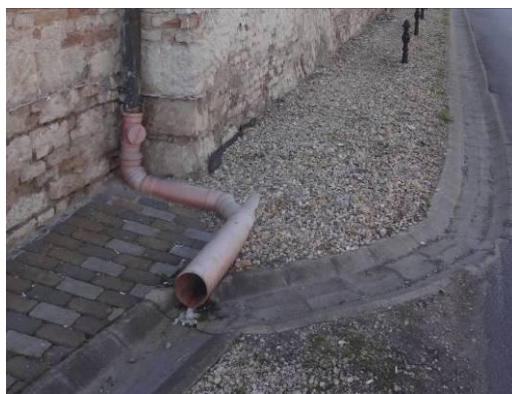
8. kép Esővíz elvezető csatorna az utca felől
