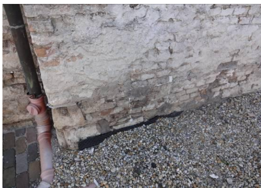
9. kép Beépített dombornyomott lemez
