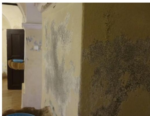
16. kép Foltosodás a karzat alatti oszlopon
