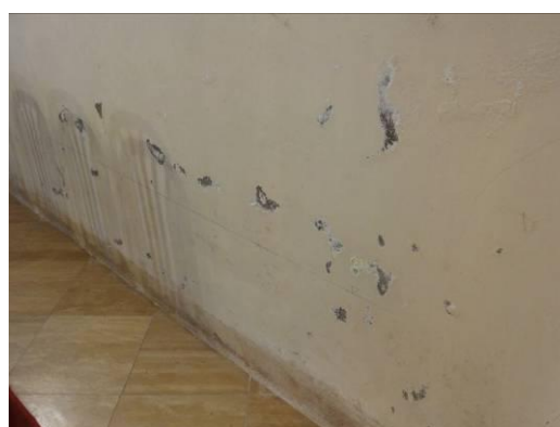
12. kép Sérülések a lábazati zónában
