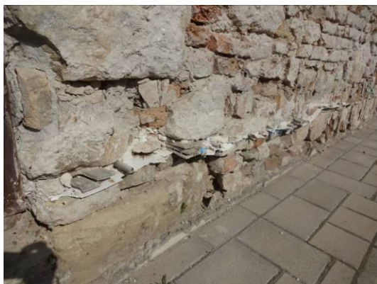
7. kép „Vízszintes falszigetelés”
